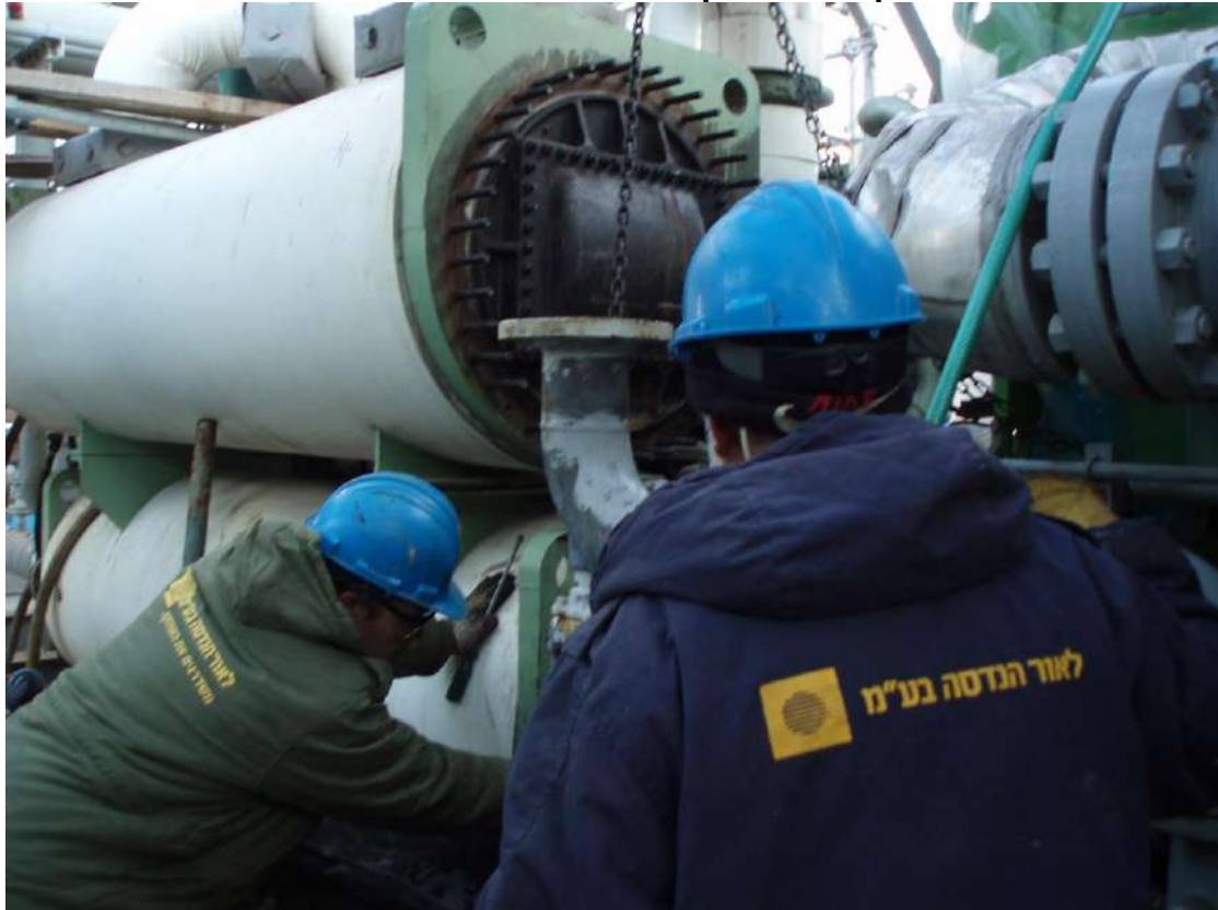
צוות לאור הנדסה במהלך עבודות ניקוי כימי והידרודינמי של מחליפי חום:
