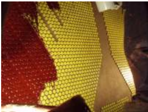
לוח צינורות (Tube Sheet) של אחד מארבעה תאים של רבע מעבה ראשי בתחנת הכוח רוטנברג באשקלון הציפוי בוצע על ידי לאור הנדסה בע"מ בנובמבר 2006
